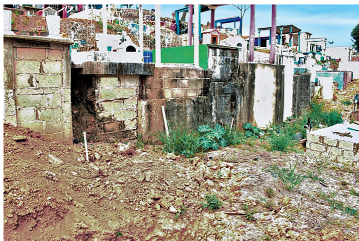
Figura 9. Detalle del costado poniente de la fosa común del Panteón Municipal de Acayucan, en donde se aprecian los tubos de PVC dejados por la Fiscalía.
