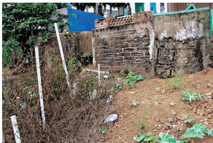
Figura 8. Detalle del costado oriente de la fosa común en el Panteón Municipal de Acayucan, en donde se aprecian los tubos de PVC dejados por la Fiscalía.
